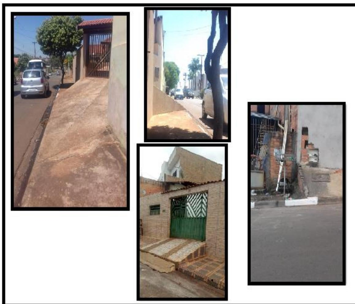
Figura 12: Fotos in loco das calçadas com rampas
