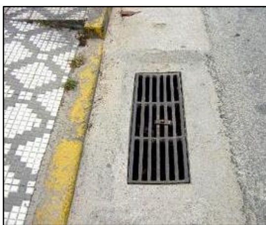
FIGURA 49 – Boca de lobo de sarjeta.
