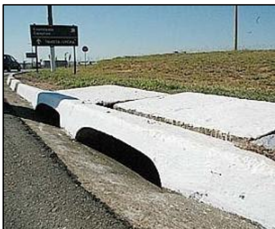
FIGURA 48 – Boca de lobo de guia.
