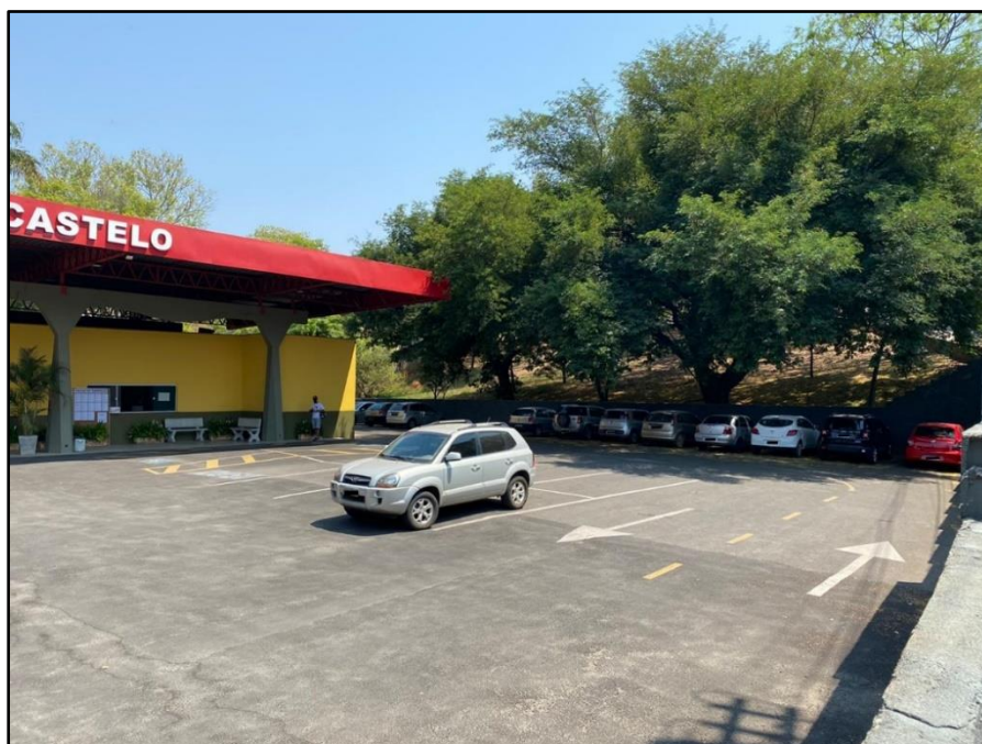
FIGURA 70 - Terminal Rodoviário Vereador João Castelo
