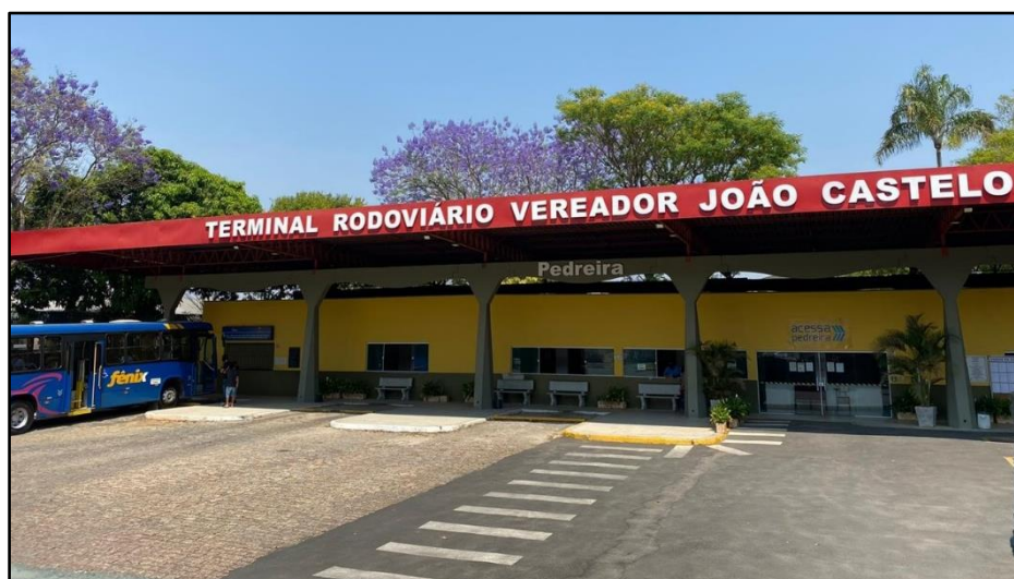
FIGURA 69 - Terminal Rodoviário Vereador João Castelo
