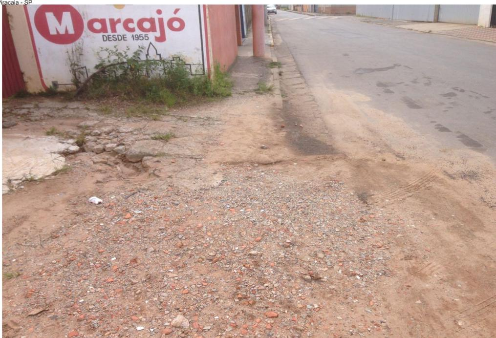
**Figura 5** – Inexistência de calçada, falta de conservação, falta de acessibilidade.
