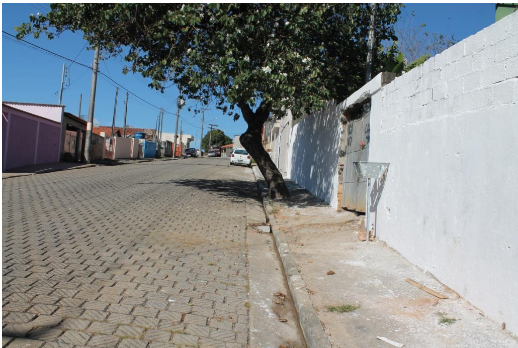
Figura 6: Árvores atrapalhando a passagem de pedestres.
