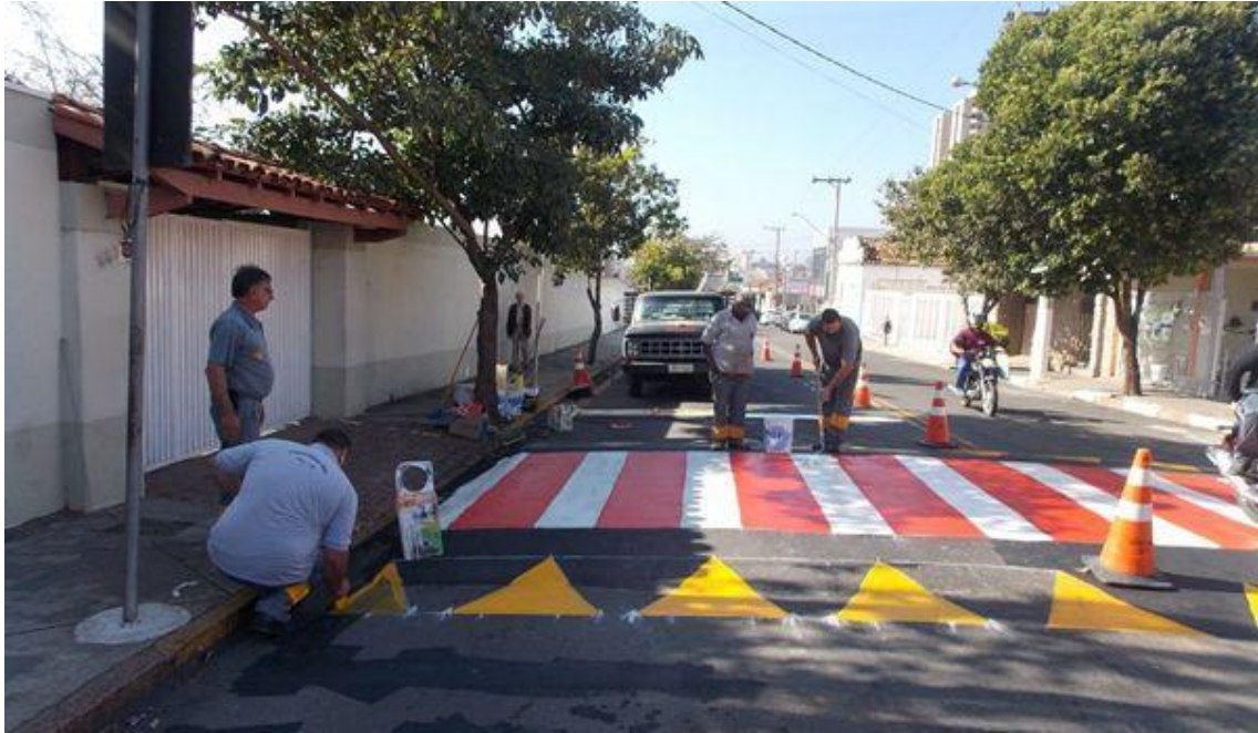
FIGURA 71 – Lombofaixa instalada em uma avenida.
